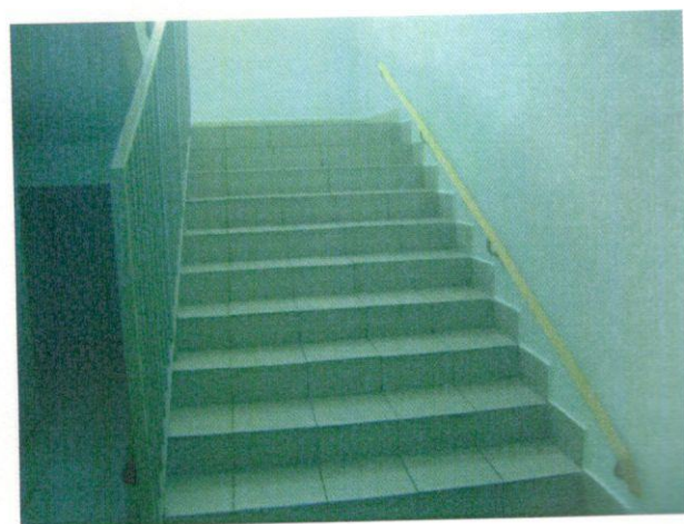
14. Лестница на второй этаж
